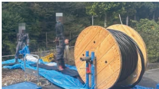
2024年 高島市環境センター 基幹改良工事
